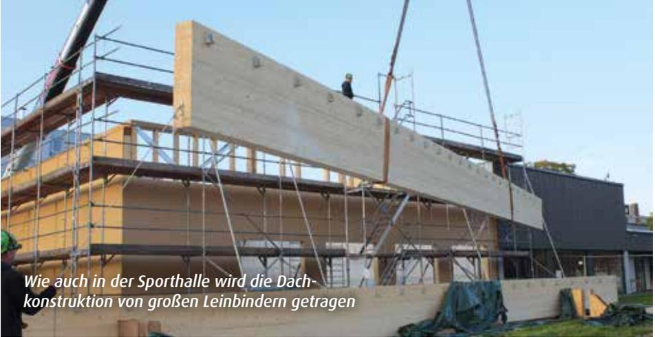
*Wie auch in der Sporthalle wird die Dachkonstruktion von großen Leinbindern getragen*
